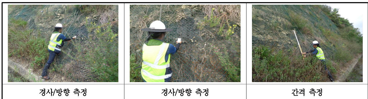
【사진 9.3.4】 불연속면 측정 현황
